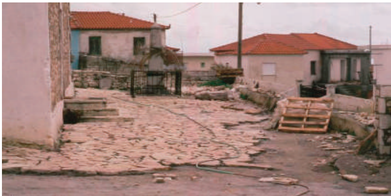
Από τις εργασίες πλακόστρωσης του προαύλιου χώρου της εκκλησίας της Κοίμησης της Θεοτόκου στο Βλάση το 2005
